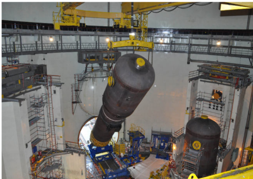
Obrázek 1: Manipulace s PG uvnitř ochranné obálky reaktoru francouzské JE Paluel
